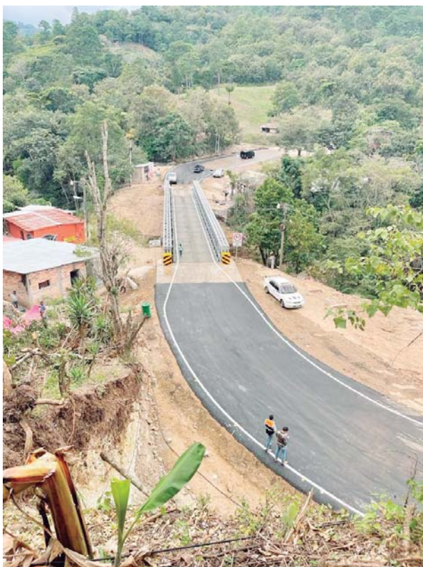
La aduana terrestre de Agua Caliente se ubica en el municipio de Santa Fe, departamento de Ocotepeque.
